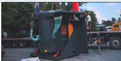
Монтаж и ввод в эксплуатацию
